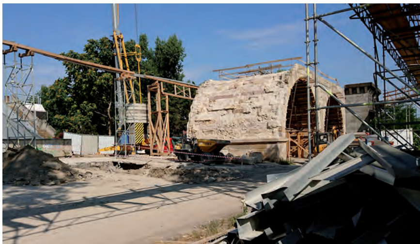
Některé oblouky na začátku rekonstrukce zcela zmizely...
